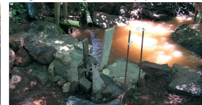
Aménagement d'un vannage sur le Maraval [81]
