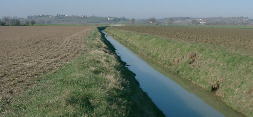
Cours d'eau rectifié - Le Vieulac
