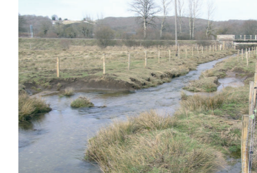
Pose de clôture sur le Viaur [12]
