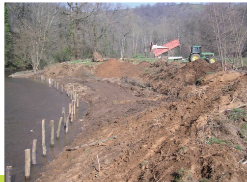
Mise en œuvre du chantier
