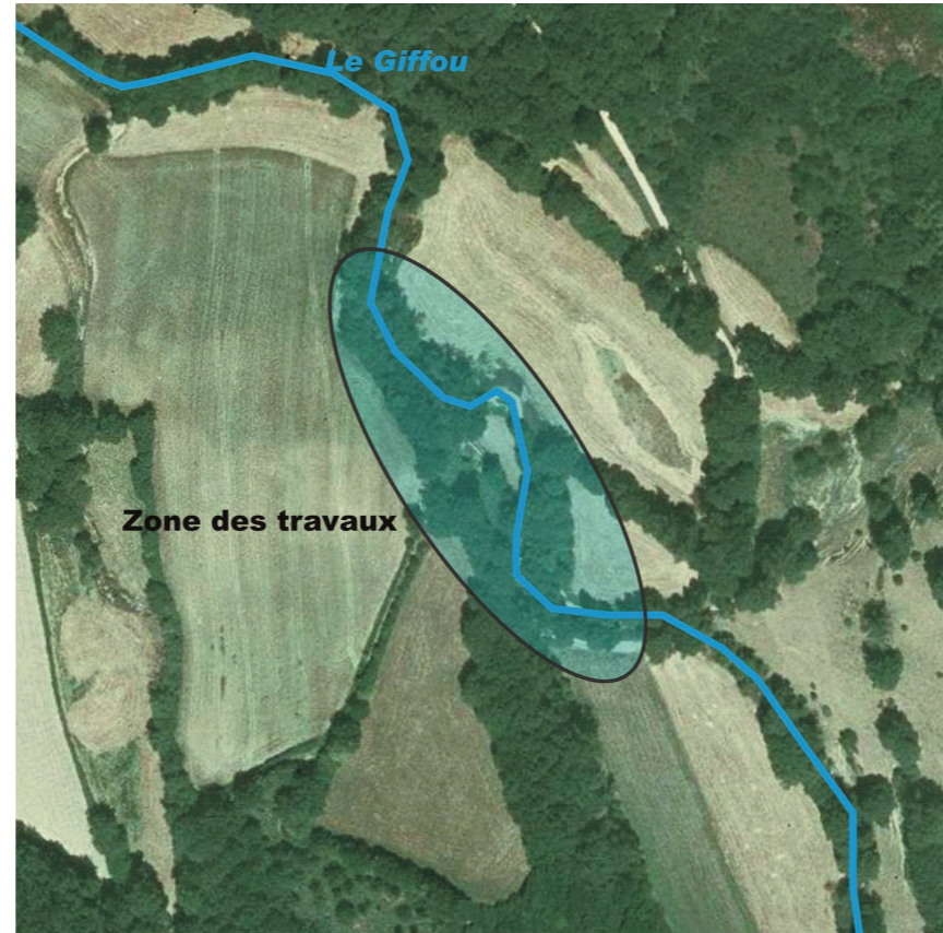
Vue aérienne du secteur de travaux
