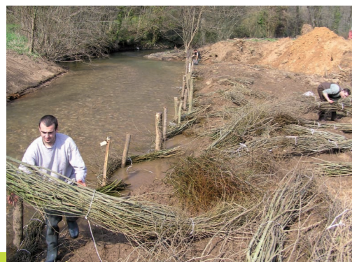
Réalisation de la fascine
