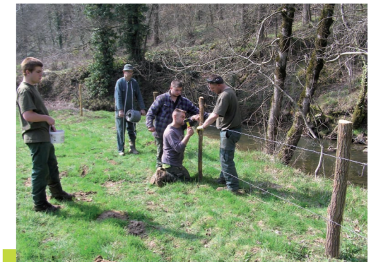
Pose des clôtures en haut de berge
