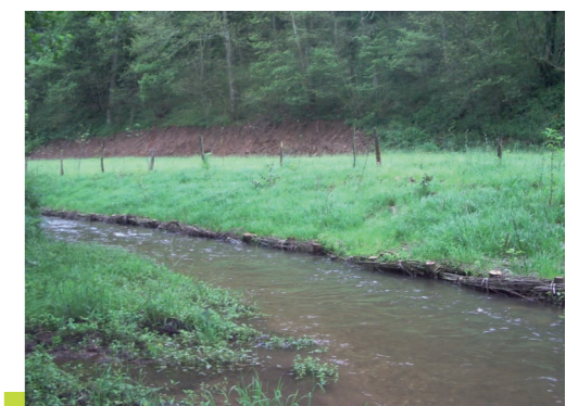
Vue des berges stabilisées
