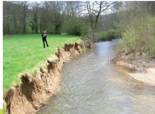
Site avant travaux
