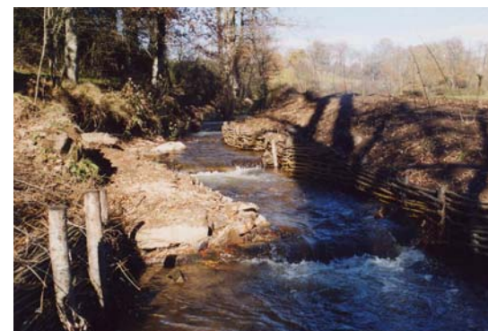
Vue du site à l'achèvement des travaux.
