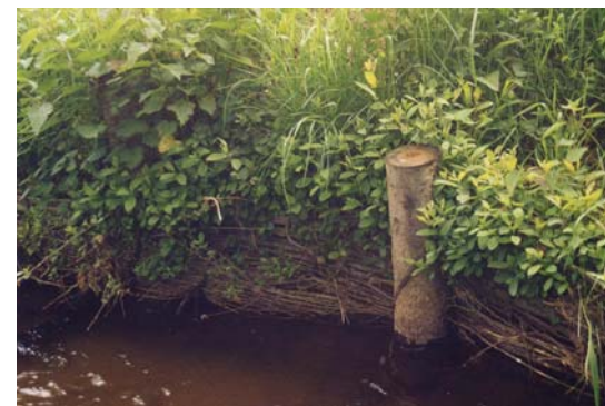
Détail du fascinage.
