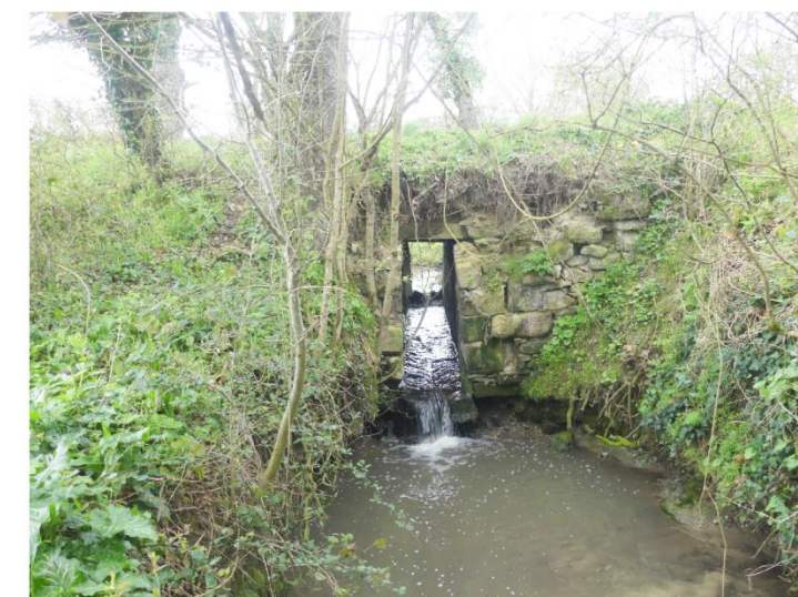
Ouvrage hydraulique et seuil sur le Girou (Orsière, Puylaurens)
