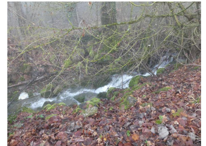
Enrochement des berges du ruisseau de Portauque à l'aval du lac de la Vernède
