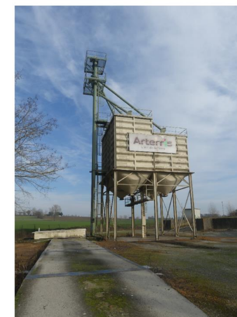
Silos Arterris (la Revelle, Teulat)
