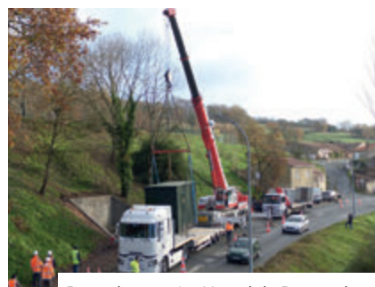
Pose du premier Nœud de Raccordement Optique à Burlats.
