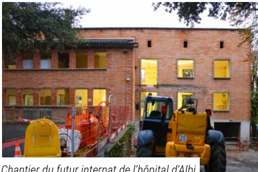
Chantier du futur internat de l'hôpital d'Albi
